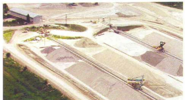
► Bild 11 • Mischanlage der Firma Vesco, Drushkovka, mit 500-m-Förderbändern
